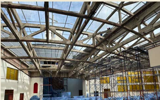
โครงสร้างด้านบนได้รับการเปลี่ยนหลังคาเมทัลชีทใหม่ทั้งหมด
