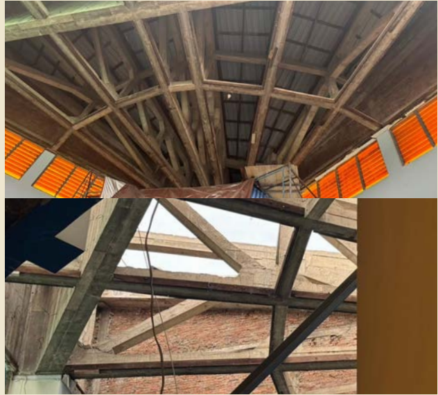
ดำเนินการซ่อมแซมคอนกรีตและเคลือบด้วยน้ำยากันซึม เปลี่ยนจากแปไม้ เป็นแปเหล็กกาวาโนซ์
