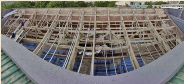
โครงสร้างด้านบนได้รับการเปลี่ยนหลังคาเมทัลชีทใหม่ทั้งหมด
